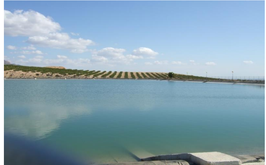
EPDM geomembrane, Torrealta-1 reservoir (courtesy M. Blanco)
